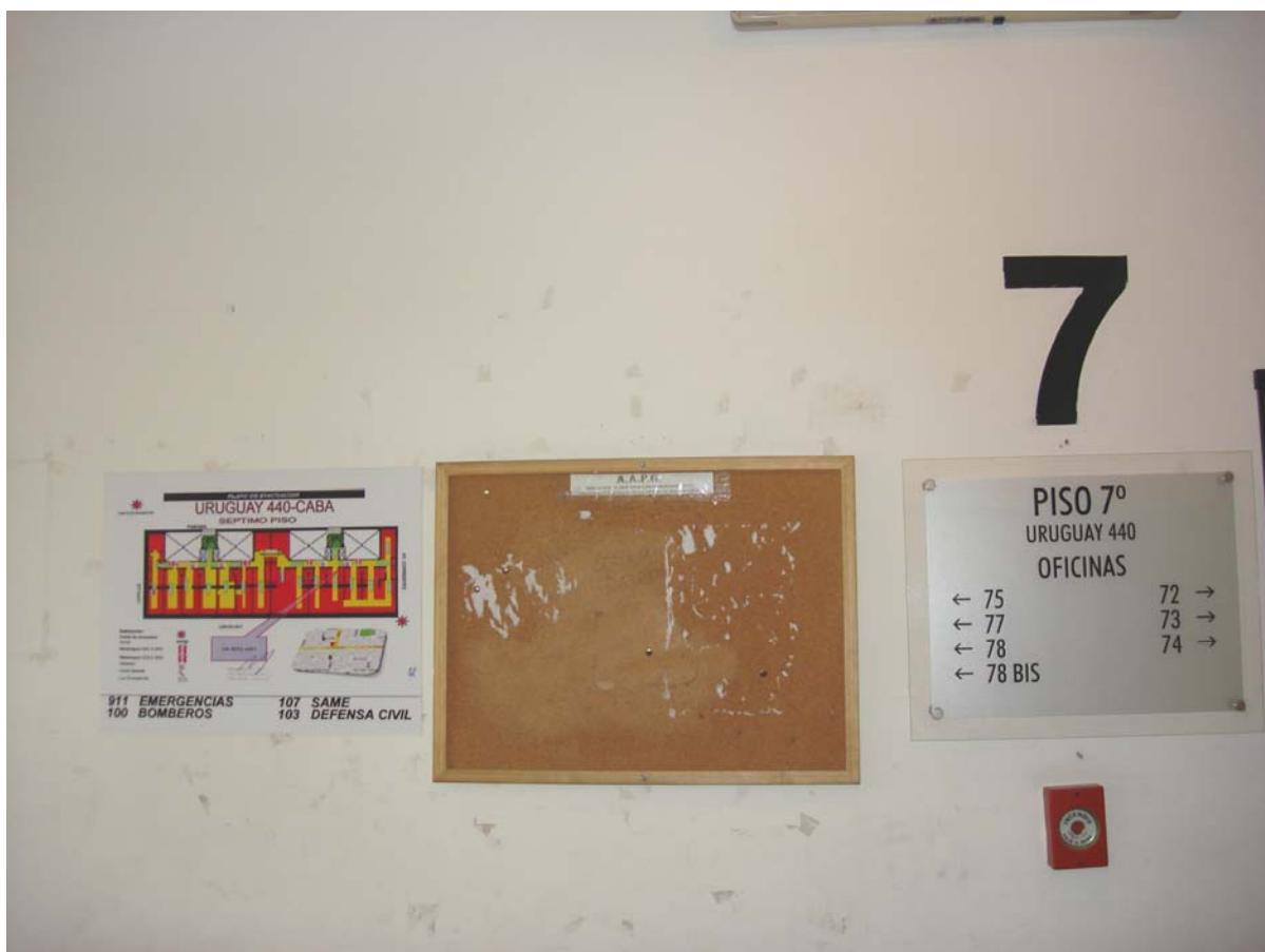
Foto N° 63: Observamos en la presente vista en la pared del palier frente a los ascensores del 7º piso un cartel de ubicación de las oficinas debajo un pulsador de la alarma contra incendio y a la izquierda el plano de evacuación con los números de urgencias.
