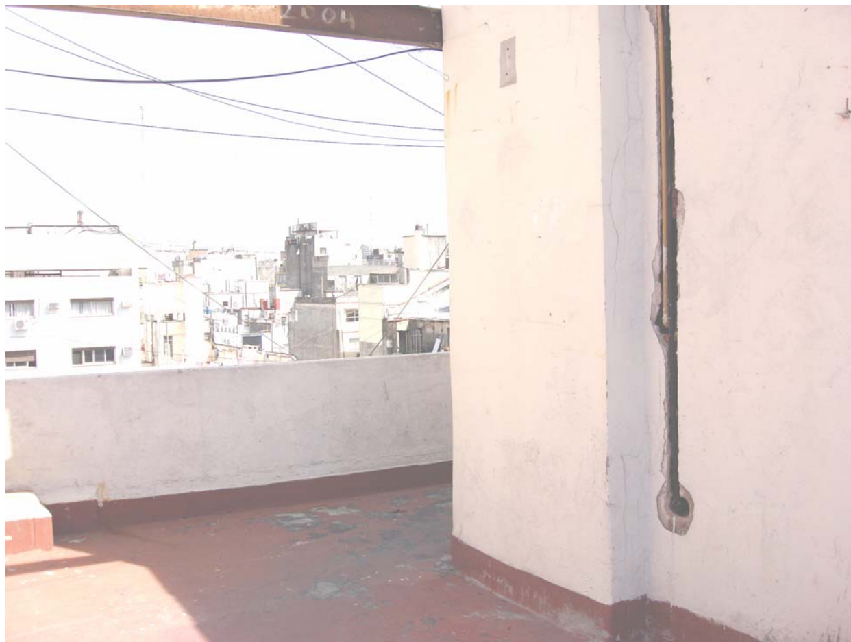
Foto N° 2: En la presente vista de un sector de la terraza se comprueba lo observado en la foto N°6 del anterior informe referente a trabajos empezados y sin terminar, una canaleta abierta en una pared con caños embutidos y sin tapar.
