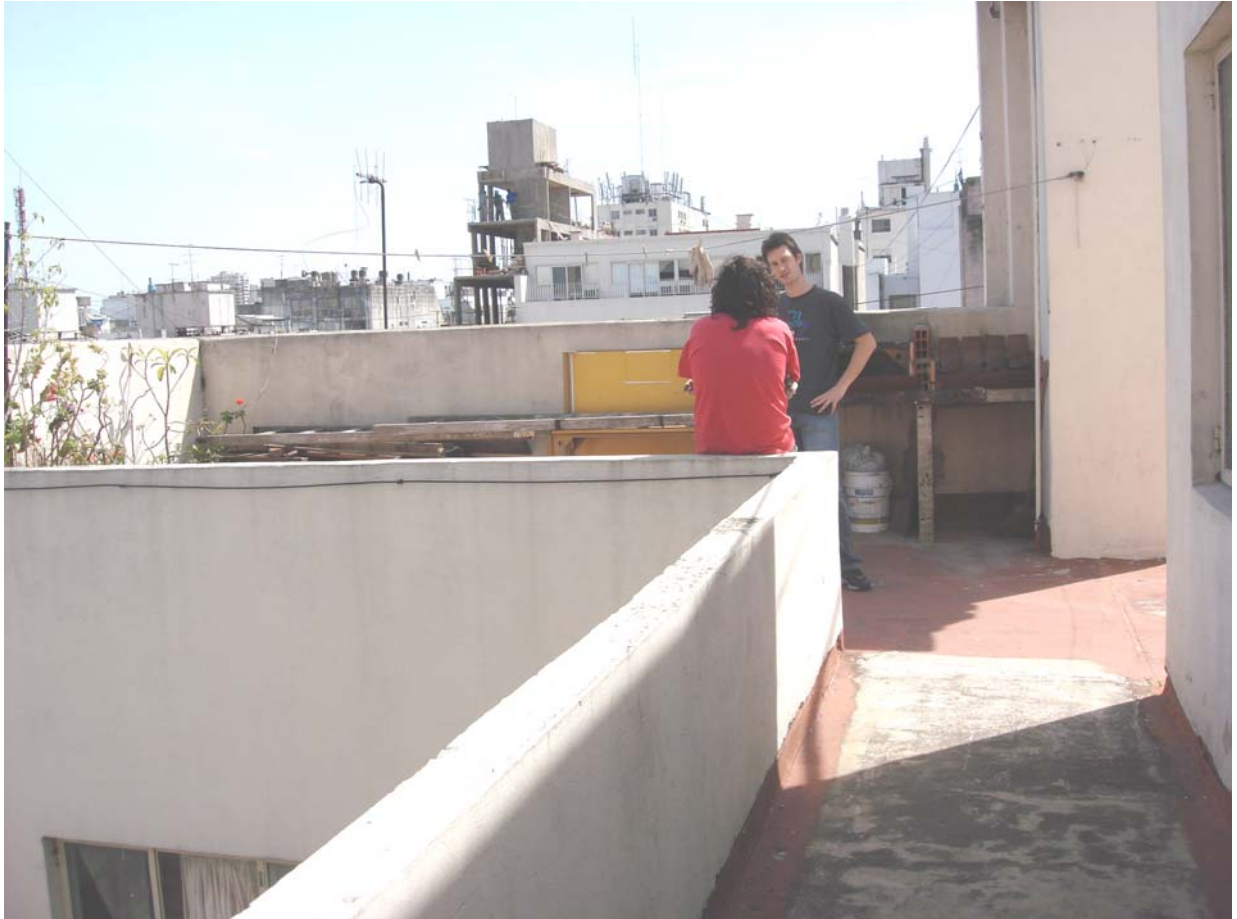
Foto N° 41: Observamos en la presente vista del 9º piso un pasillo que conduce a otro sector de la terraza donde se puede ver en el fondo una parrilla y a la izquierda un murete de baja altura, que, por ser este un espacio transitable que usa el personal como lugar de reunión o para fumar debiera tener mas altura.
