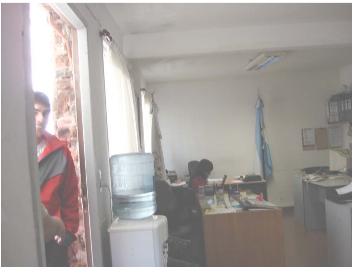
Foto N° 9: Observamos en la presente vista en el salón de usos múltiples los empleados trabajando en sus escritorios y en la entrada detalles de albañilería sin terminar, el estado de este salón hace un año y siete meses era similar al actual (Ver en la foto N° 14 del informe 5.07.09).
