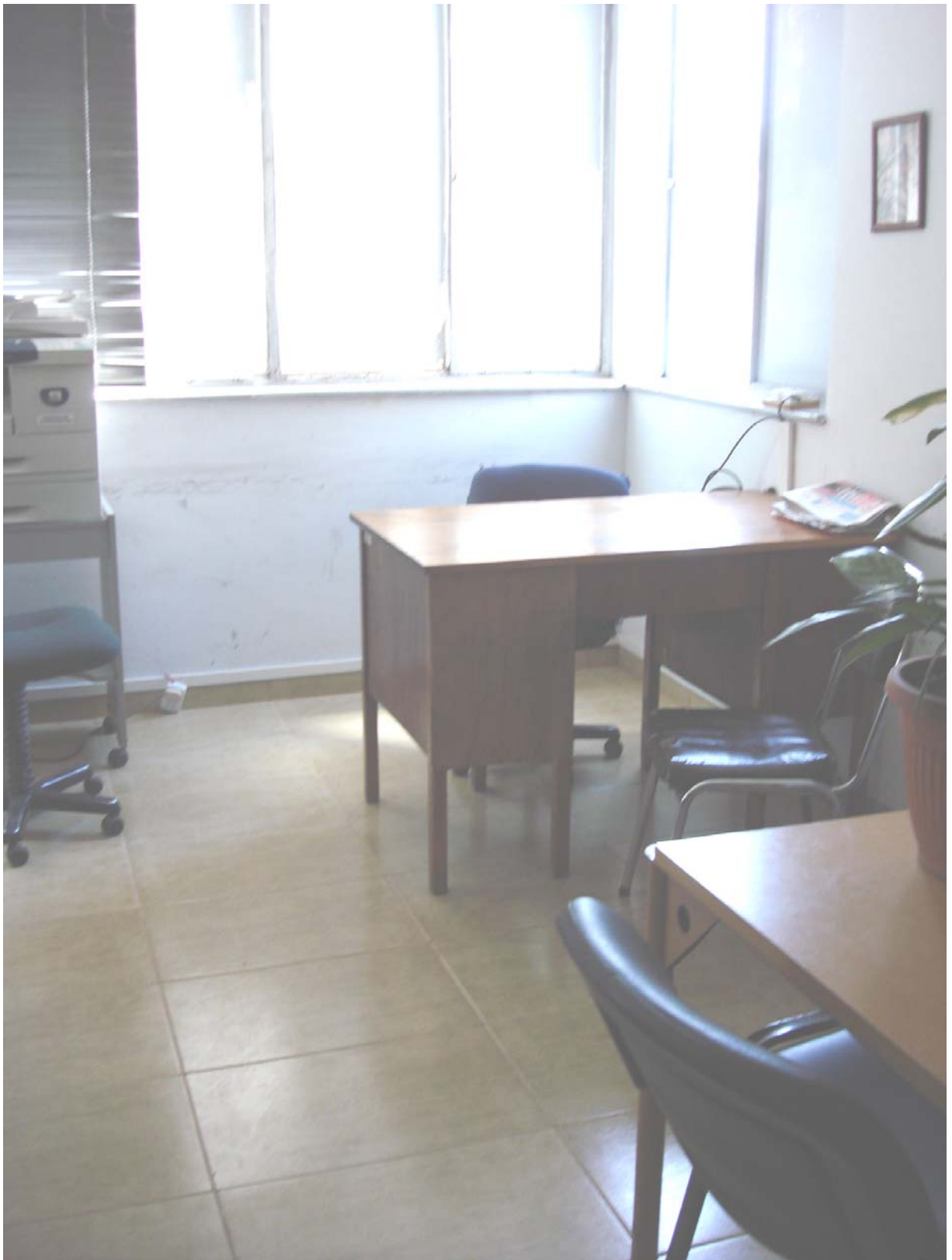
Foto Nº 28: Observamos en la presente vista una oficina del 9º piso donde se ha cambiado el piso de pinotea por un solado de cerámica esmaltada. Es de
