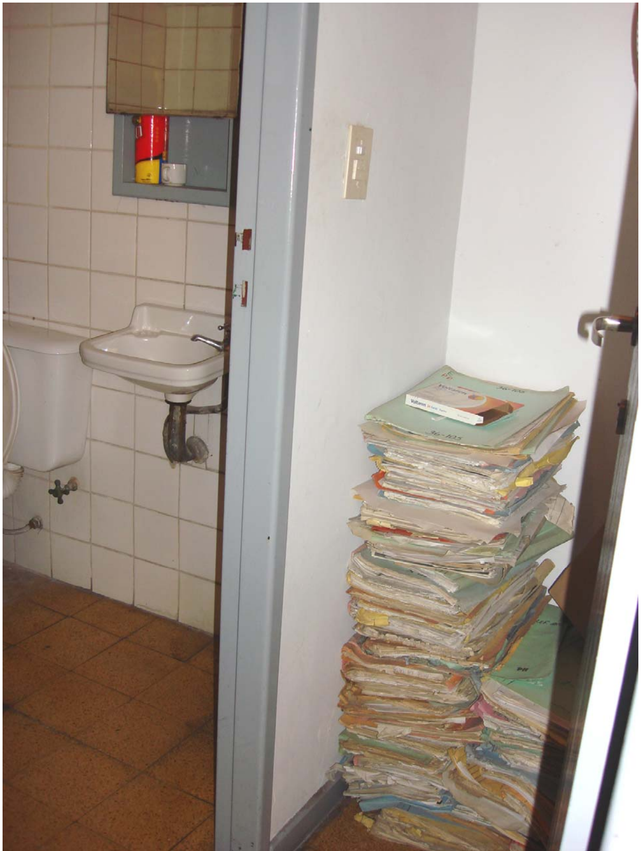
Foto Nº 68: Observamos en la presente vista un baño del 7º piso y el ante-baño usado como depósito de expedientes.
