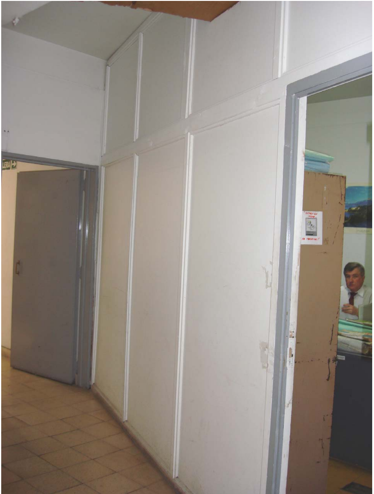
Foto N° 89: Observamos en la presente vista del pasillo general del 5º piso un tabique formado por bastidores de madera y láminas de material tipo “Chapadur”.
