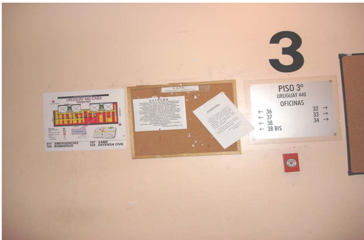
Foto N° 92: Observamos en la presente vista en el palier del 3° piso el plano de evacuación, un cuadro que orienta hacia donde están las diferentes oficinas, un panel para colocar informaciones y un pulsador del sistema de alarma contra incendio.
