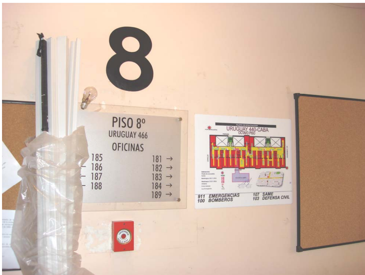
Foto N° 48: Observamos en la presente vista un pasillo del 8º piso frente a los ascensores el cuadro de ubicación de las oficinas y a la derecha el plano de evacuación y debajo el pulsador para la alarma contra incendio.
